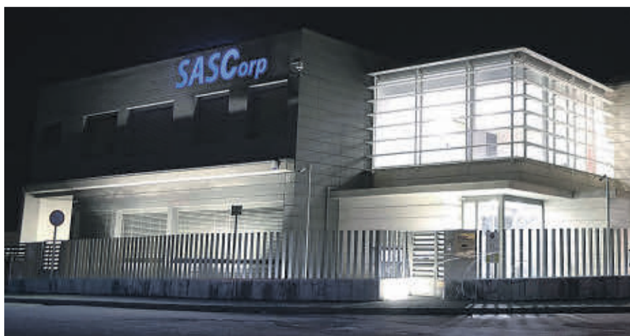
Fachada de las oficinas centrales de SASCorp. EE
