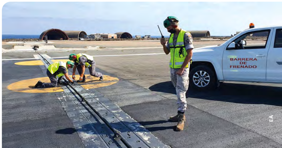
Revisión de la barrera de frenado de pista en la Base Aérea de Gando, en las Islas Canarias
