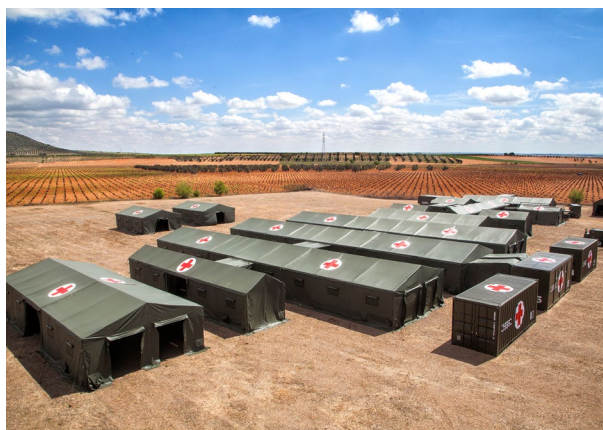
Instalaciones sanitarias. Tecnove
