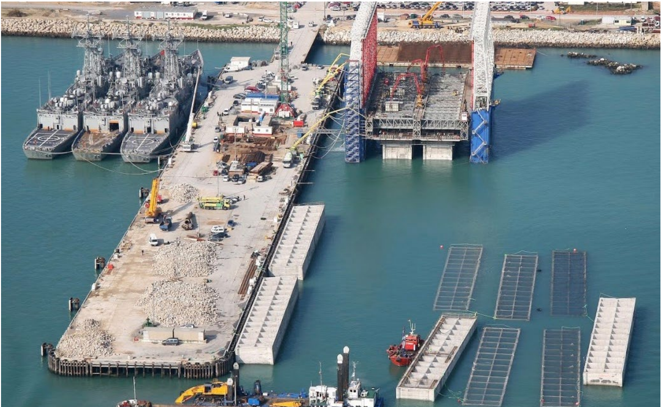
Rehabilitación del muelle de Rota. Acciona
