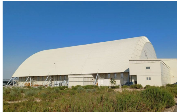
Hangar del A400M en la base aérea de Zaragoza. Acciona
